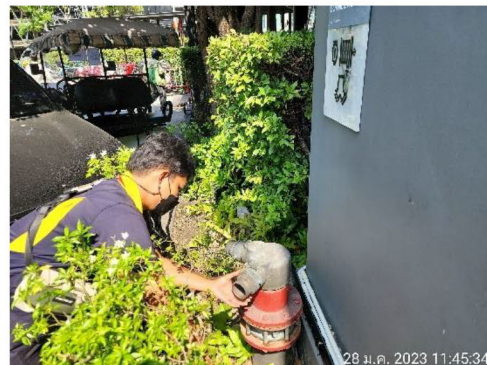
ภาพที่ 3-8 ตรวจสอบหัวรับน้ำดับเพลิง
