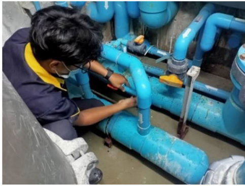
ภาพที่ 3-1 ตรวจสอบการแตกหรือรั่วซึมของ ท่อประปา
